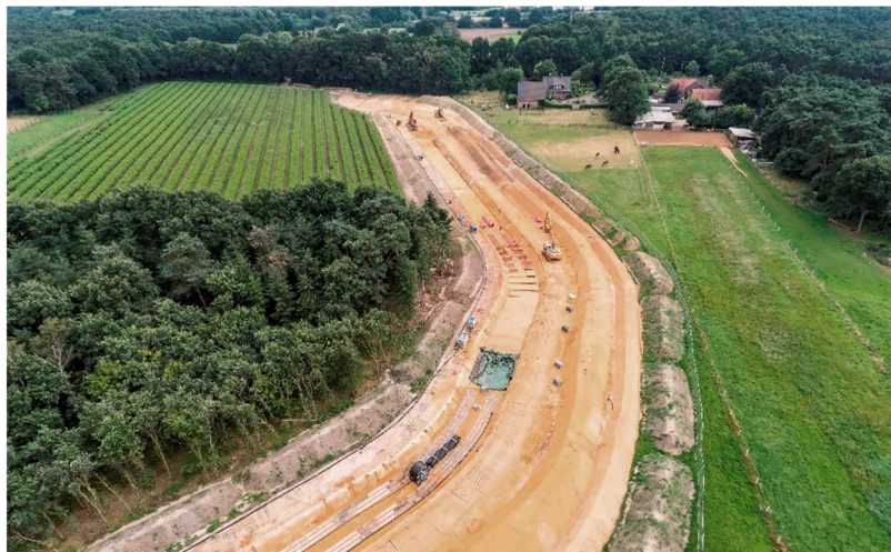
Erdkabelbaustelle bei einem Amprion-Wechselstromprojekt in Borken 2016 (Bildquelle: ARGE Amprion Schutzrohranlage in Borken)
